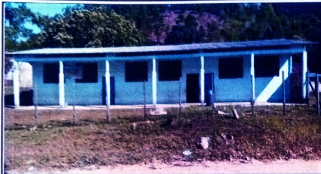
Foto1: CAMBIO DE TECHO DE AULAS
