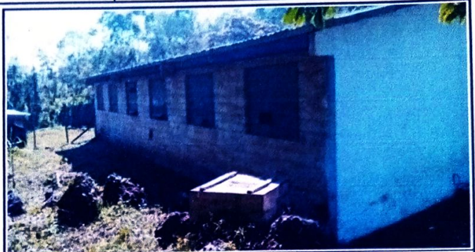
Foto 2: SUSTITUCION DE CAMBIO DE VENTANAS Y VALCONES
