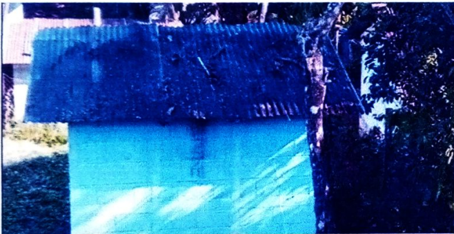
Foto 3: SUSTITUCION DE TECHO DE LAMINAS
